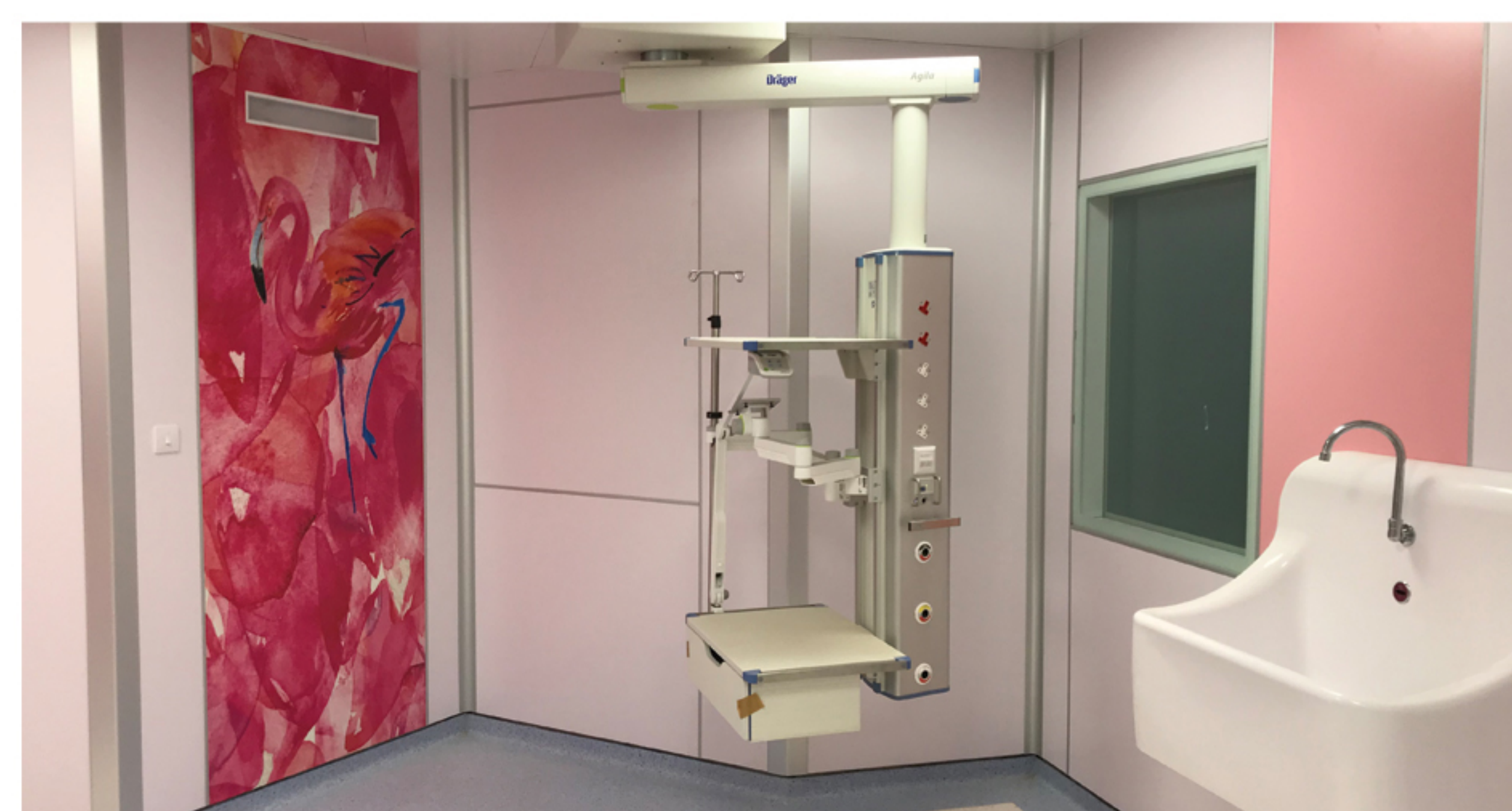
Ruang NICU Wahran Est. F.C., Sakaka KSA, Saudi Arabia
